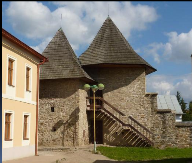
Bašta na SV strane( opevneniafoto: Glos 2010)
